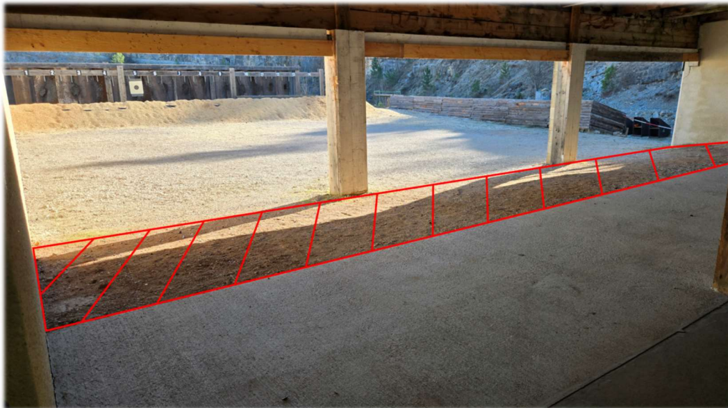
Figure 1 : Extension de la dalle béton au pas de tir à 25 mètres
