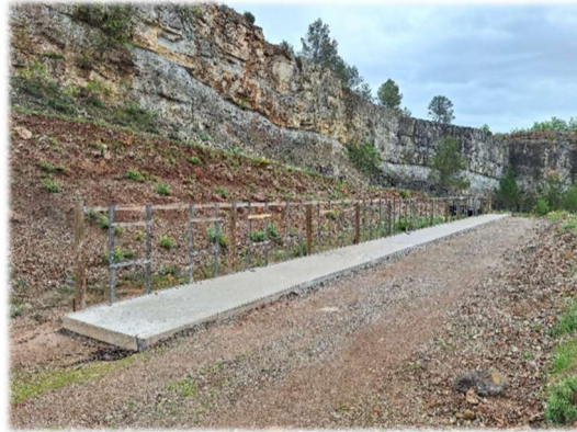
Figure 1 : Aperçu de la dalle au pas de tir à 200 mètres
