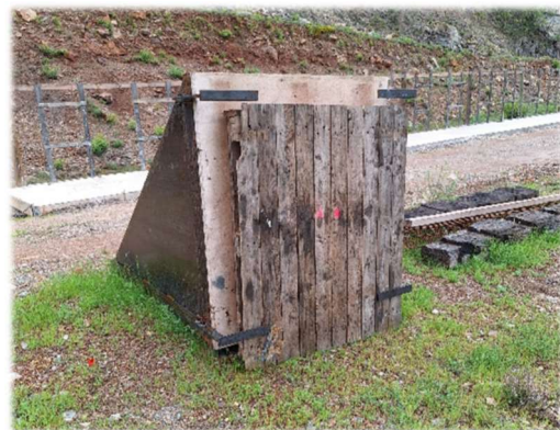
Figure 2 : Piège à balles au pas de tir à 200 mètres
